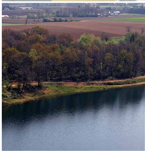
Le barrage du Gabas
