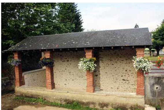
Le lavoir de Pontacq rénové par les employés municipaux en 2013
